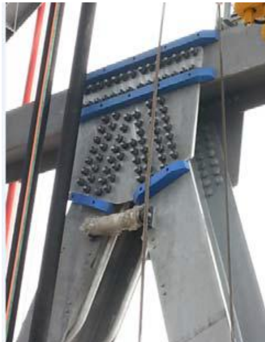
Aplicação em estrutura de torre de perfuração 3
